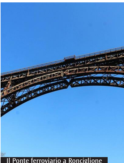
Il Ponte ferroviario a Ronciglione
